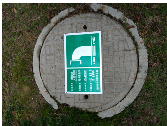
图4-5 雨水接管口及标识牌
